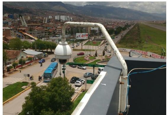
Instalación de cámara PTZ – Ovalo 28 de Julio
