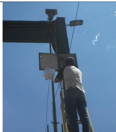
Proceso de instalación de amplificador
