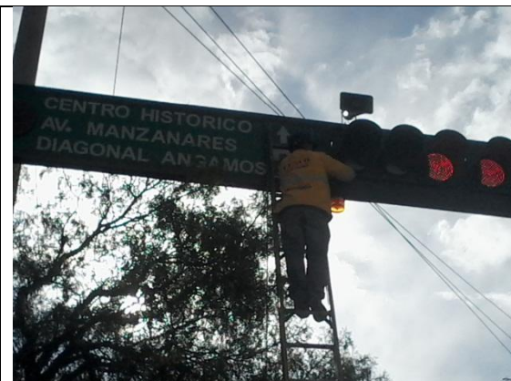
Proceso de instalación de megáfonos
