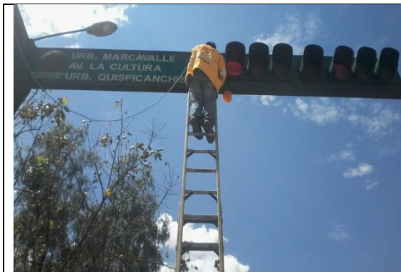
Proceso de instalación de circulinas
