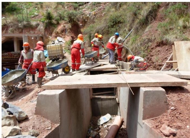
PROTECCION QUEBRADA SOLTEROHUAYCO
