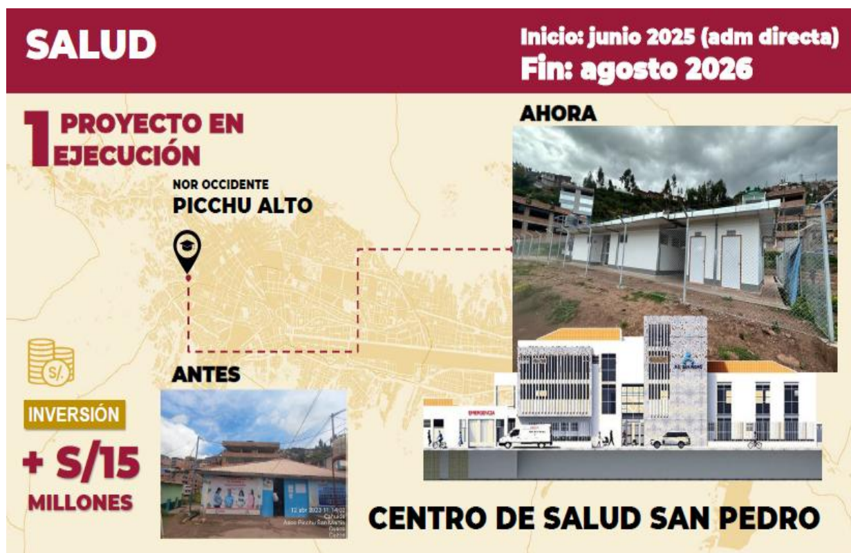
Figura 44: Proyecto en Ejecución en Salud, Centro de Salud San Pedro.
