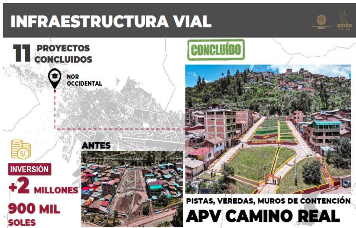
Figura 29: Proyectos concluido en Infraestructura Vial – Pistas, veredas y muros de contención APV. Camino Real.
