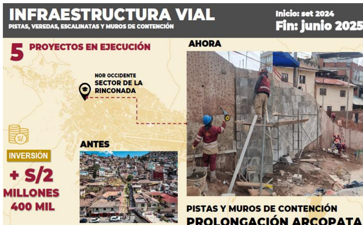
Figura 55: Proyectos en Ejecución en Infraestructura Vial – Pistas y muros de contención en Prolongación Arcopata.
