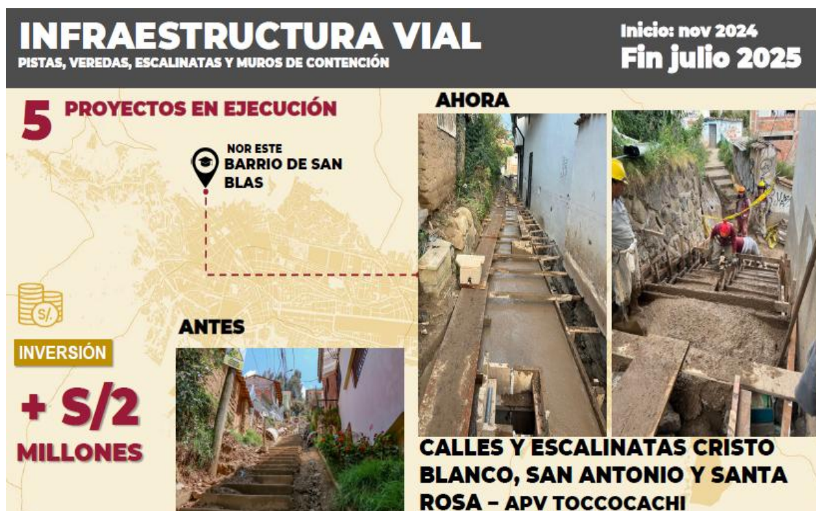
Figura 54: Proyectos en Ejecución en Infraestructura Vial – Calles y Escalinatas en Cristo Blanco, San Antonio y Santa Rosa – APV. Toccoachi.
