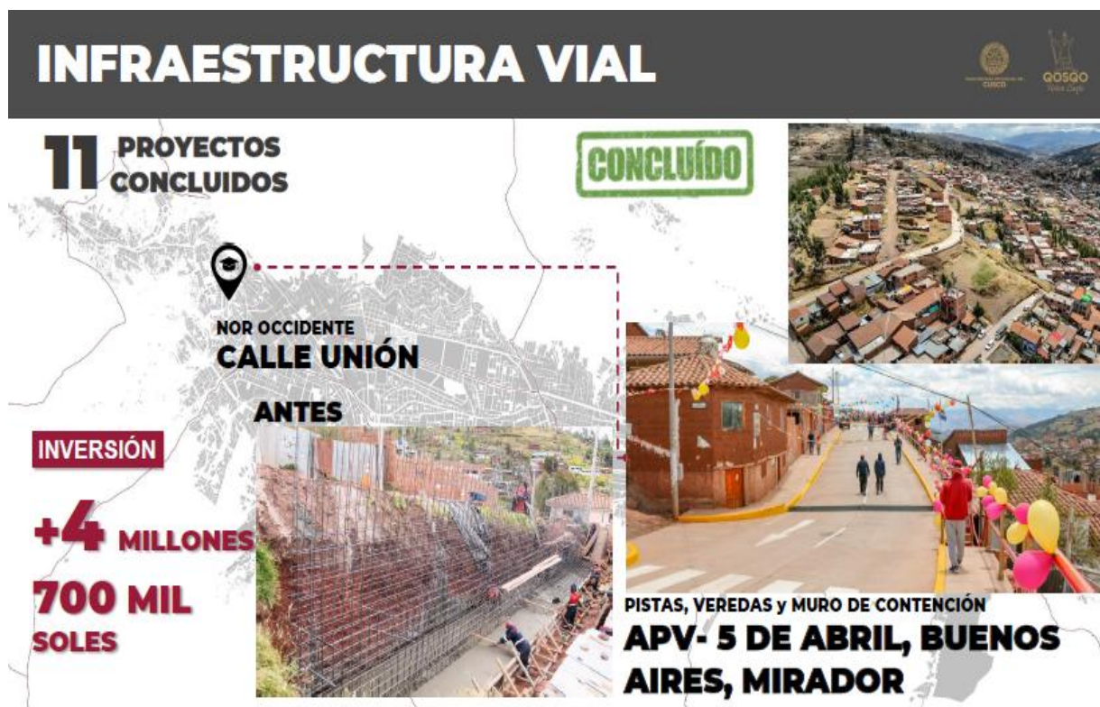
Figura 22: Proyectos concluido en Infraestructura Vial – Pistas, veredas y muros de contención en APV. 5 de Abril, Buenos Aires, Mirador.
