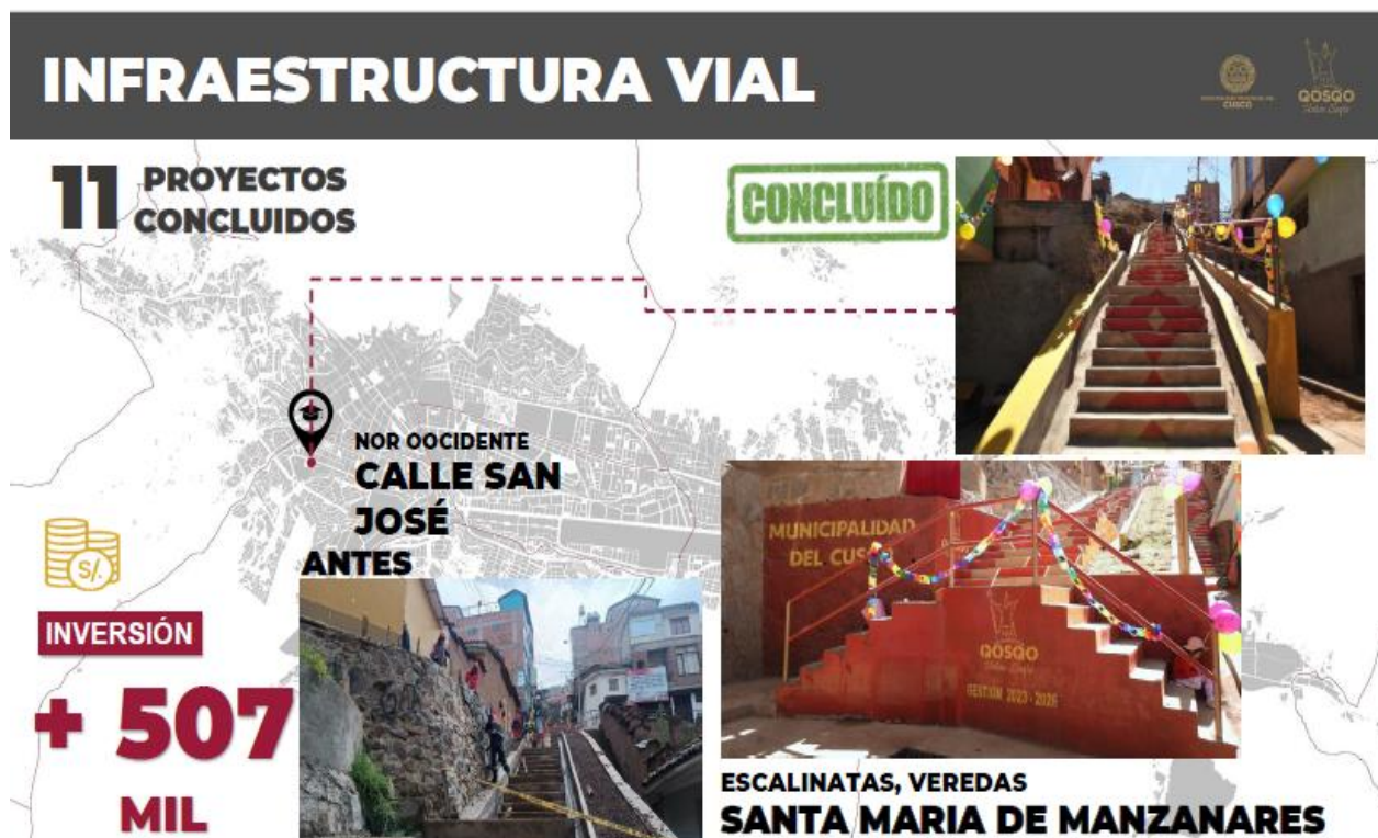
Figura 23: Proyectos concluido en Infraestructura Vial – Escalinatas y veredas en Santa María de Manzaneras.
