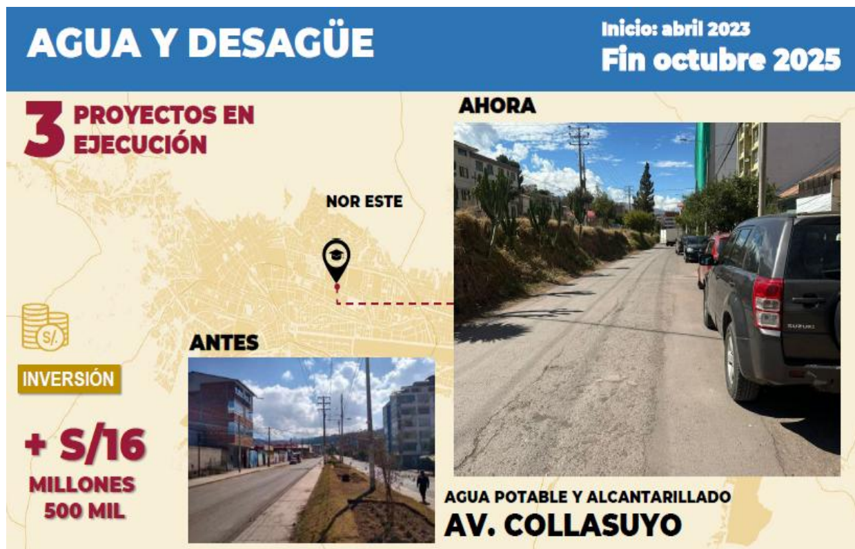
Figura 47: Proyectos en Ejecución en Agua Potable y Alcantarillado en Avenida Collasuyo.
