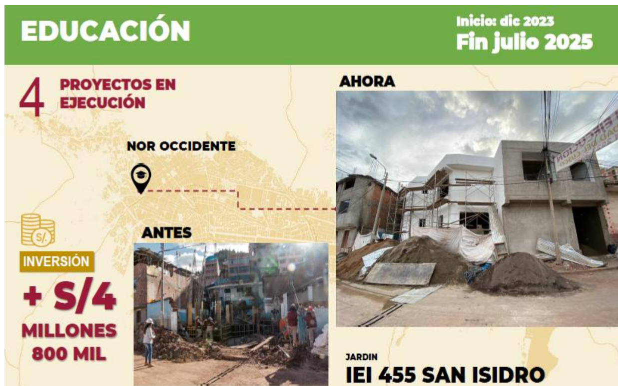
Figura 41: Proyectos en Ejecución en Educación, Jardín I.E.I. 455 San Isidro.
