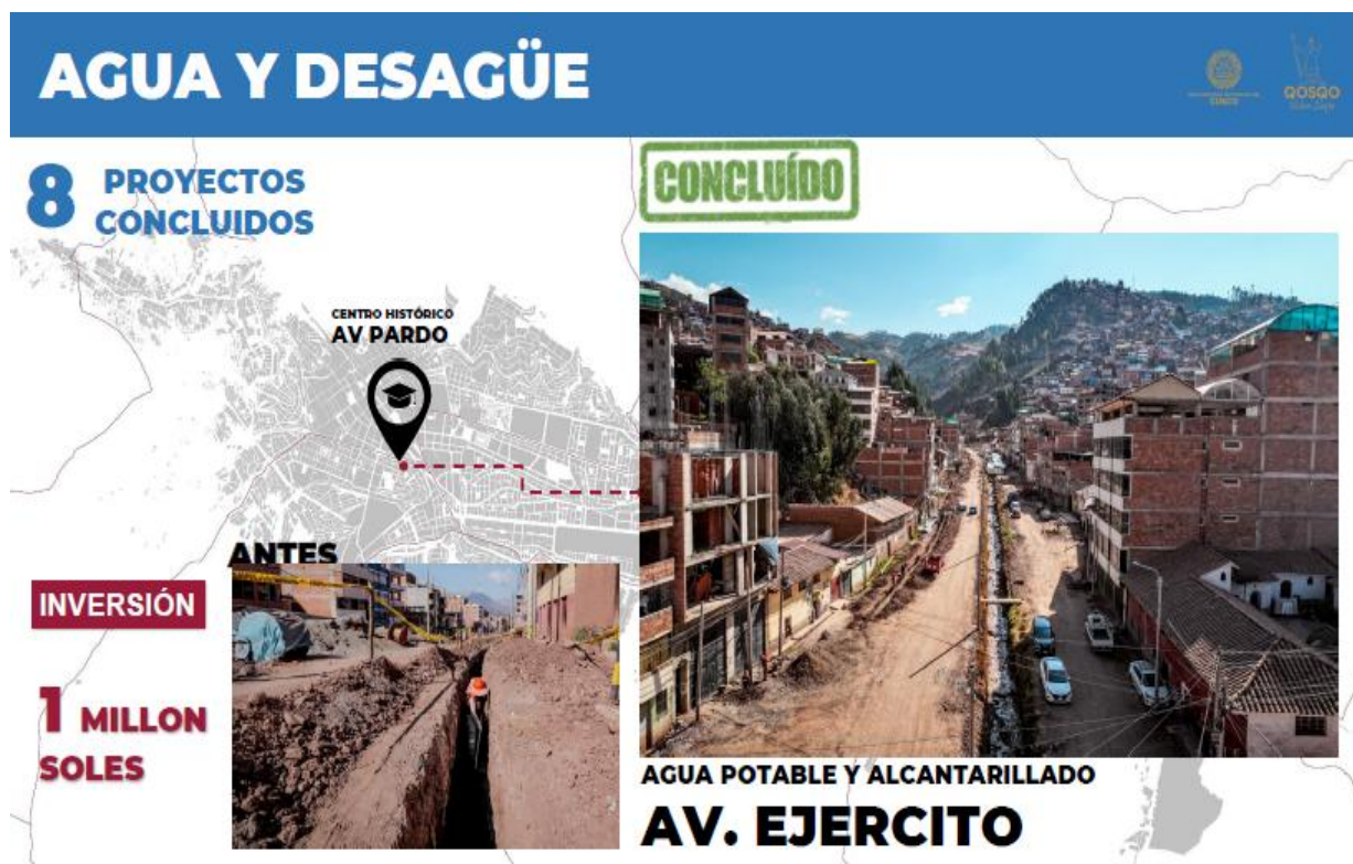
Figura 16: Proyectos concluidos en Agua potable y Alcantarillado en Avenida Ejército.
