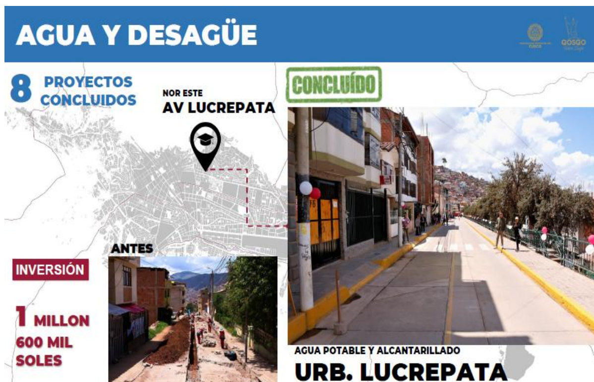
Figura 12: Proyectos concluidos en Agua potable y Alcantarillado en Urbanización Lucrepata.
