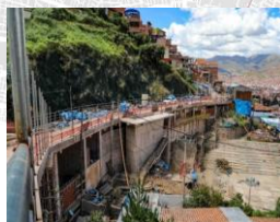
PUENTE, PISTAS Y VEREDAS - ZONA NOR ESTE APV TOCOCACHI
