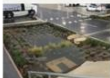
Parterres Inundables (Biorretención)
