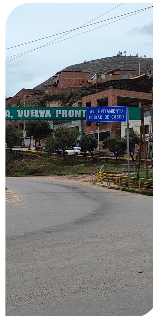
Figura 73: Vía de Evitamiento Fuente: Foto Transitec 2024
